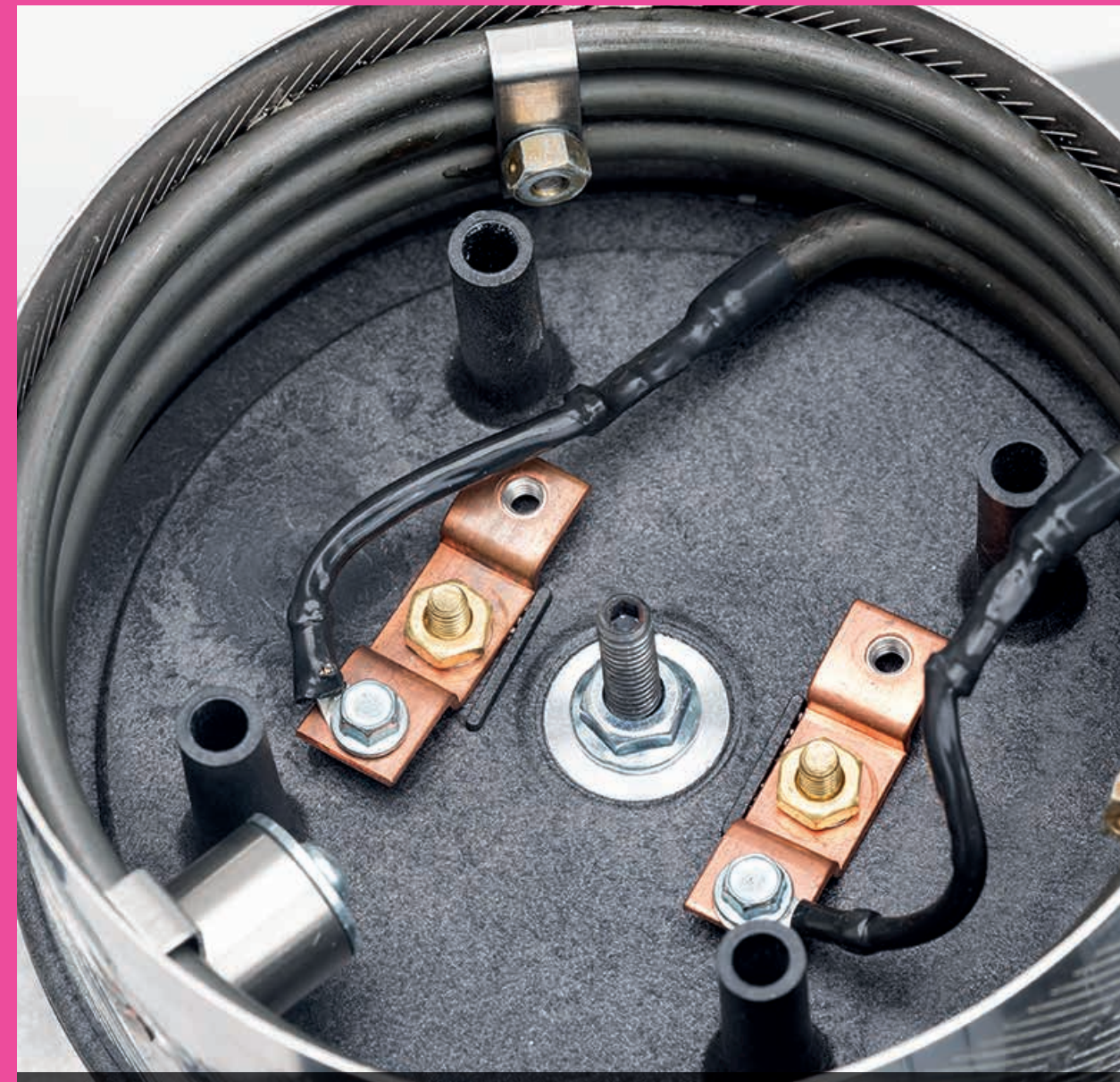
Genauer Blick auf die Stromverteilung im Inneren des Spinnkopfkäfigs.
